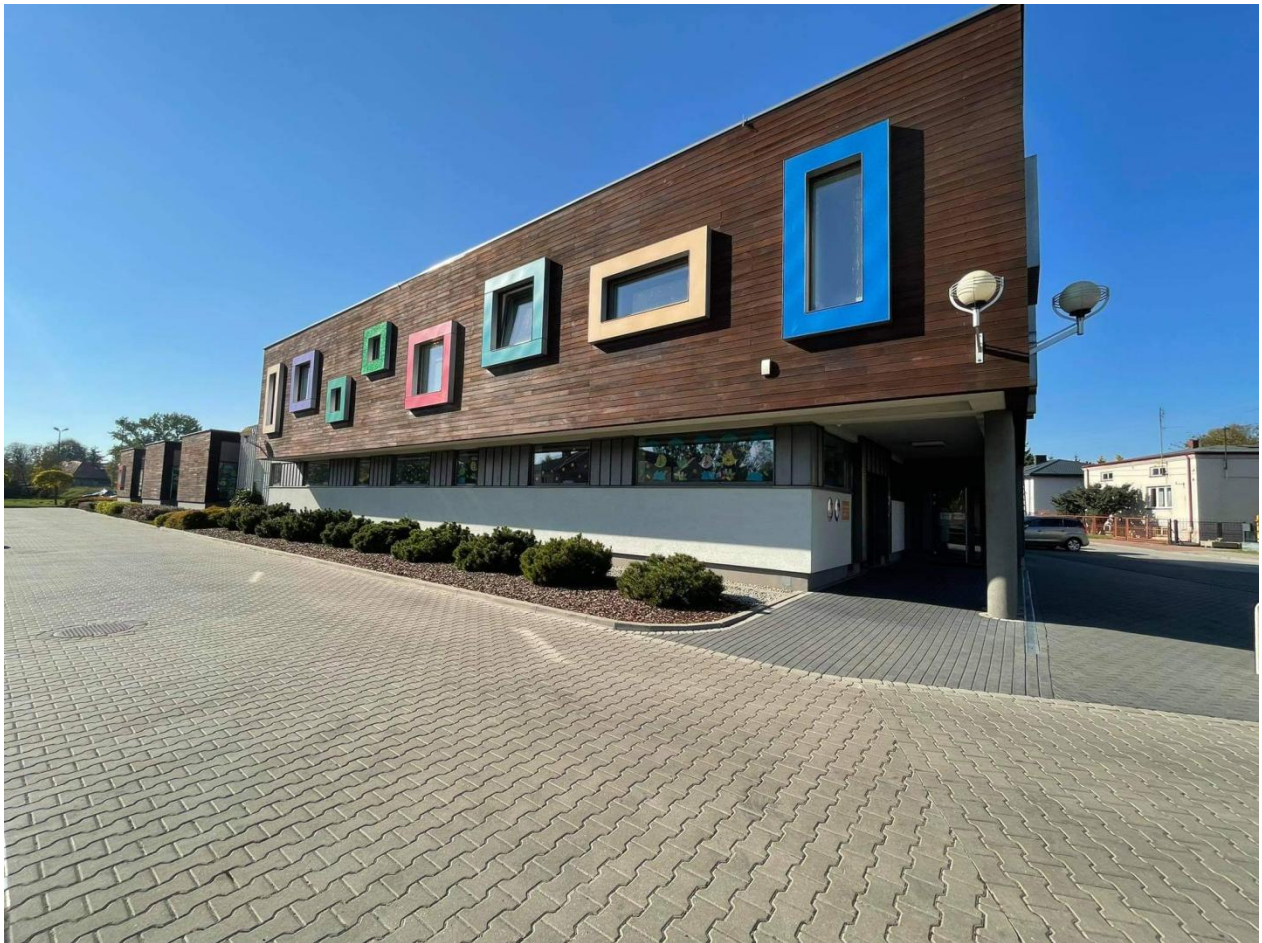
Widok boku budynku Żłobka, od strony parkingu przy ul. Murarskiej 1
